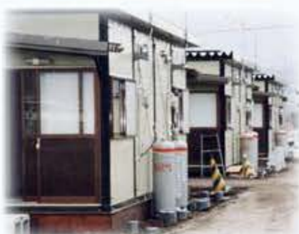
LPガスを設置した仮設住宅
