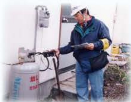
1軒1軒調査点検するガス屋さん
